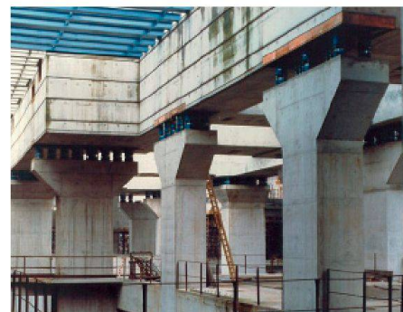
01 Federgelagertes Turbo-Generator-Maschinenfundament in Belgien, 1000 MW, Rohbau (Foto: Peter Trombik)
