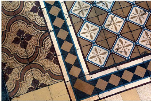
Einfach, schön und dauerhaft: Zementbodenfliesen von Villeroy & Boch aus dem 19. Jahrhundert aus einem abgebrochenen Baumeisterhaus an der Zürcher Seefeldstrasse 48 (Foto: Baugeschichtliches Archiv der Stadt Zürich)
