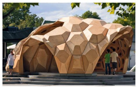
01 Die Struktur des Pavillons entspricht den mechanischen Beanspruchungen. Im Zentrum mit kleiner Krümmung sind die Kassetten über 2 m gross, während sie zum Rand hin teilweise nur 0.5 m gross sind (Fotos: Proiektteam)
