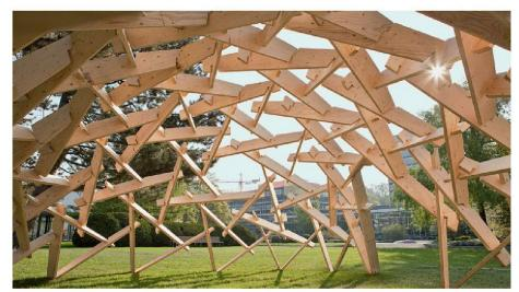
01 Pergola ETH Science City. Die Lage der Balken wird über Schraubverbindungen gesichert. Diese wirken hauptsächlich in den stark geneigten Balken, dort, wo die Reibung zwischen den Elementen nachläset
