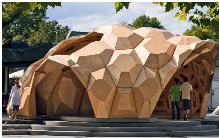
01 Die Struktur des Pavillons entspricht den mechanischen Beanspruchungen. Im Zentrum mit kleiner Krümmung sind die Kassetten über 2 m gross, während sie zum Rand hin teilweise nur 0.5 m gross sind (Fotos: Projektteam)
