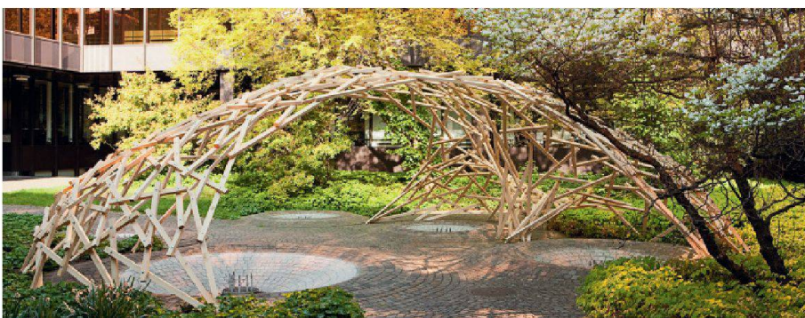
02 Tragwerk im Hof der ETH-Architekturfakultät (Fotos: Peter Hauser)
