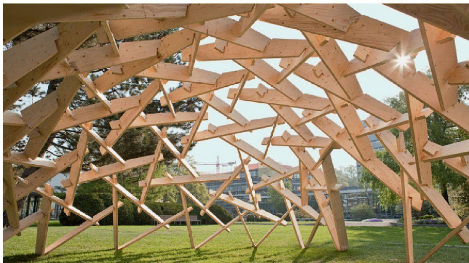
01 Pergola ETH Science City. Die Lage der Balken wird über Schraubverbindungen gesichert. Diese wirken hauptsächlich in den stark geneigten Balken, dort, wo die Reibung zwischen den Elementen nachlässt
