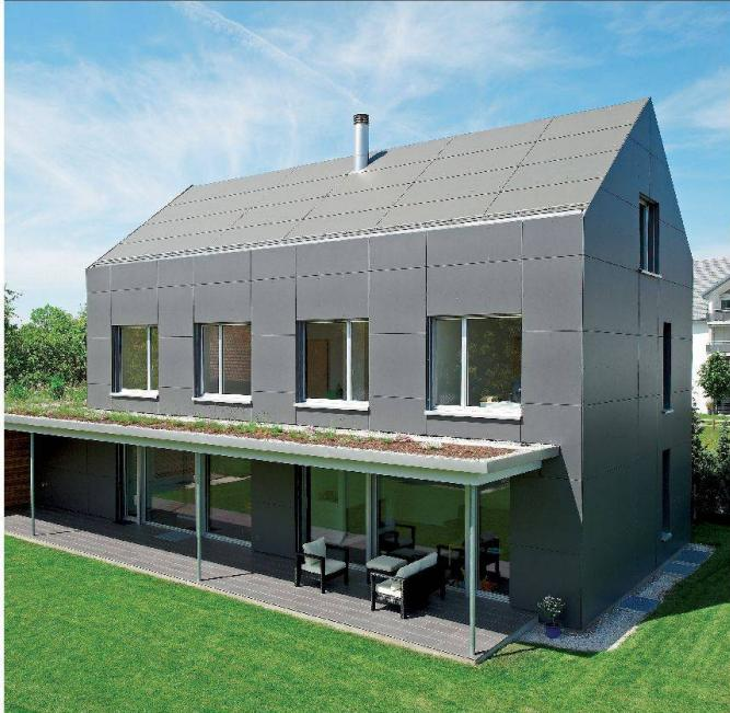
Dachgestaltung, die durch ihre zurückhaltende, flächige Wirkung überzeugt. INTEGRAL PLAN ist bereits ab einer Dachneigung von 6° möglich.
