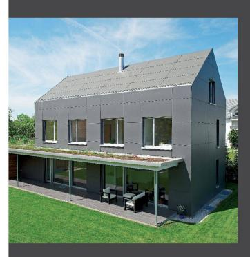
Dachgestaltung, die durch ihre zurückhaltende, flächige Wirkung überzeugt. INTEGRAL PLAN ist bereits ab einer Dachneigung von 6° möglich.
