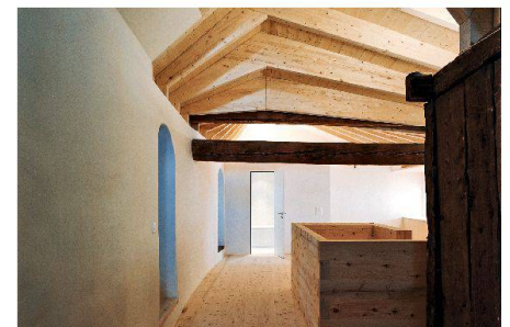
04 Das Fallwerk im OG erlaubt ein Maximum an Raumhöhe. Rechts im Bild die Stüvetta, links die beiden Gewölberräume
