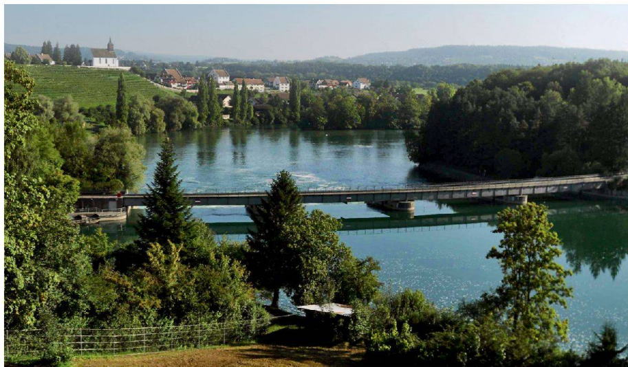
01 Das Hauptwehr des Kraftwerks Rheinau staut den Rhein, wodurch insgesamt ein nutzbares Gefälle von 10,5m entsteht. Bis zu 400m³ Wasser pro Sekunde werden auf der linken Seite des Wehrs durch zwei Kaplan-Turbinen mit einer Gesamtleistung von 36800 kW geleitet und über einen 300m langen Stollen dem Rhein unterhalb der Rheinschleife wieder zugeführt. Ursprünglich floss sämtliches Wasser an der Klosterinsel (hinter dem bewaldeten Hügel rechts im Bild) vorbei und anschliessend um die Halbinsel von Rheinau (Fotos: Autor)
