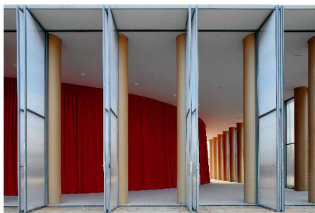
04–05 Eine «Säulenreihe» aus Kartonrohren (Ø=60 cm, h=595 cm) umfasst den temporären Konzertsaal in L'Aquila, dessen Wand zur Schalldämmung aus Sandsäcken besteht (Fotos: Fabio Mantovani)
