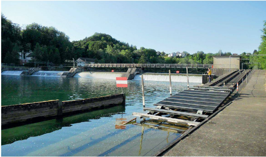
02 Das obere Hilfswehr staut den Rhein und gewährleistet, dass trotz geringer Restwassermenge das ganze Jahr die gesamte Flussbreite benetzt ist. Dank dem Wagen (rechts im Bild), der durch Drahtseile gezogen und über Kamera und Gegensprechanlage vom Kraftwerk zentral gesteuert wird, können kleine Boote das Wehr passieren. Eine gleiche Vorrichtung besteht auch beim unteren Hilfswehr sowie beim Hauptwehr. Aktuell gibt es bei keinem der Wehre eine Vorkehrung, die die Fischgängigkeit garantieren würde
