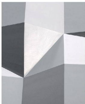
Die 1.0 mm feine Körnung des Putzes, der auf die Putzträgerplatten aufgebracht wurde, verleiht der Fassade eine so glatte Oberfläche, dass sie ausschnittsweise wie ein konkretes Kunstwerk wirkt (Foto: Gasser Fassadentechnik AG)
