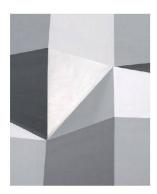
Die 1.0 mm feine Körnung des Putzes, der auf die Putzträgerplatten aufgebracht wurde, verleiht der Fassade eine so glatte Oberfläche, dass sie ausschnittweise wie ein konkretes Kunstwerk wirkt (Foto: Gasser Fassadentechnik AG)
