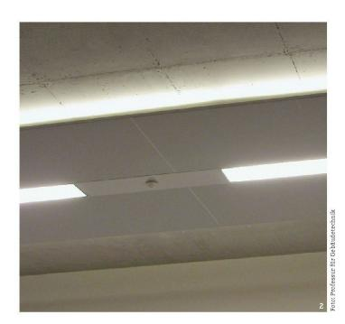
Aufgrund der sehr moderaten Wassertemperaturen, die für die thermische Bewirtschaftung des Systems erforderlich sind, lässt sich das Heptapanel optimal im Verbund mit Wärmepumpen betreiben. In der Installation, wie sie im HPZ eingesetzt wird, ermöglichen die grosse Wärmetauschfläche des Paneels und der durch die Bauteilaktivierung bedingte 24-h-Betrieb zudem eine effektive Regeneration des Erdreichs. Die Lüftung, die über die gezielte und bedarfsgesteuerte Abluftfassung ins Paneel integriert
