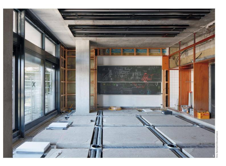
Im sanierten HPZ-Gebäude wird begreifbar, wie das LowEx-Konzept in der Praxis funktionieren kann: Fassaden werden nur teilweise ersetzt, der grosse Teil des ursprünglichen Baukörpers bleibt erhalten und wird mit komplexen technischen Einbauten ergänzt. Die Koordination der Haustechnik übernimmt eine Software – das Zusammenspiel von Forschungsteam und Baupraxis jedoch musste von allen Projektbeteiligten gemeinsam neu entwickelt werden.
