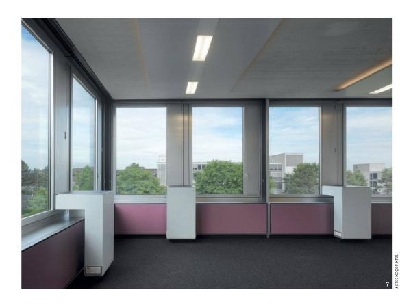
7 Nach der Sanierung sind die Räume mit multifunktionalen Deckenpaneelen und Airboxen® ausgestattet
