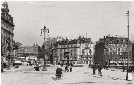
01 Bellevue 1902 (Foto: A. Moser, Baugeschichtliches Archiv, Zürich)
