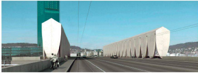
04+05 «Südost»: Drei Häuser mit markanten weissen Betonfassaden vor V-förmigem Stahltragwerk stiften Identität – zwei Häuser entlang der Hardbrücke (11 m hoch, 30 m lang) und eines quer darunter. Die Perrondächer werden als zusätzliche Bewegungsflächen genutzt (Bilder: Olgiati Arch.)
