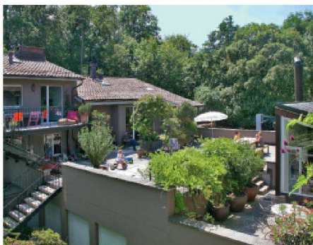
02 Blick von einer der Mietwohnungen auf die Gemeinschaftsterrasse (Alle Fotos: Architekturbüro Vera Gloor AG)
