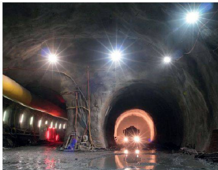
01 Ceneri-Basistunnel: Portal Vigana Kaverne West mit Bretella links
