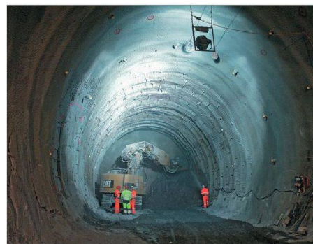
03 Baggervortrieb in der Weströhre (Fotos: AlpTransit Gotthard AG)
