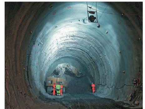
03 Baggervortrieb in der Weströhre (Fotos: AlpTransit Gotthard AG)
