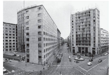
03 Die beiden Palazzi Montecatini in Mailand (erbaut 1936 und 1952) an der Kreuzung Via della Moscova und Via Filippo Turati und am Largo Guido Donegani (Foto: Gio Ponti Archives)
