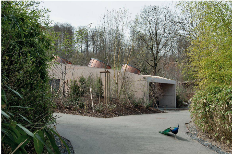
01 Im Primatenhaus werden ab 2012 Gelbbrustkapuziner und Totenkopffäffchen leben. Es wird, wie auch das Flamingohaus, für Besucher nicht zugänglich sein (Fotos: Heinrich Helfenstein)
