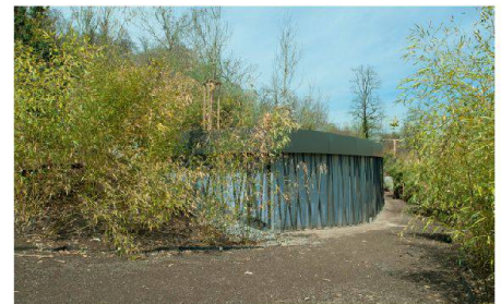
03 Flamingohaus mit Fassade aus Polycarbonatplatten
