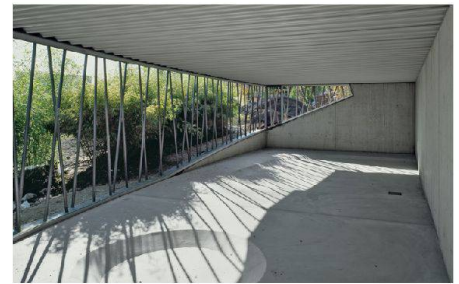
02 Flamingohaus, noch ohne Verkleidung
