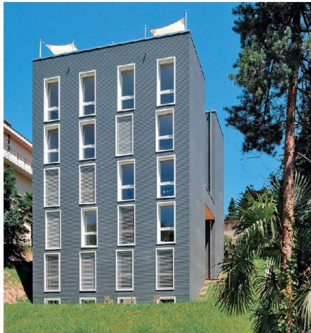
01 Wohnhaus Casa Montarina, Lugano. Der sechsgeschossige Bau ist komplett aus Holz konstruiert. Der Grundriss misst 12.4 x 12.4 m, die Gesamthöhe knapp 18 m (Foto: Jürg Zimmermann)
