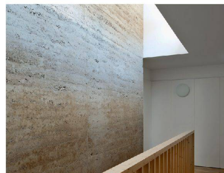
02 Das Material für die Stampflehmwände stammt aus dem Kelleraushub (Fotos: Thomas Jantscher)
