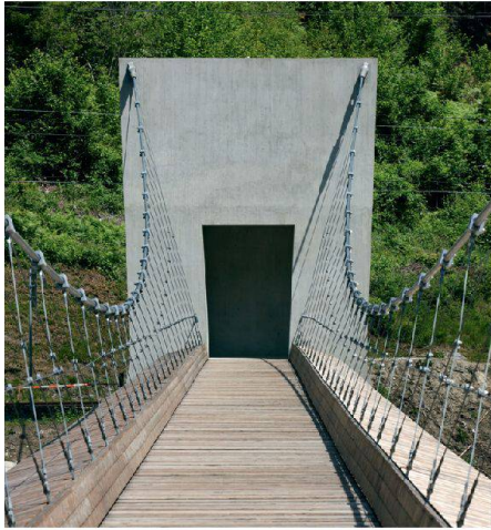
05 Die rautenförmig eingehängten Seile versteifen die Tragkonstruktion
