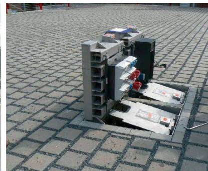
Unterflurelektranten
