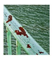
Korrodiertes Geländer einer Brücke, das einer Instandsetzung bedarf (Foto: photocase/Bearbeitung: Red.)
