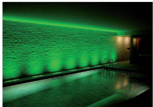
LED RGB Wandbeleuchtung Hallenbad EFH
