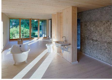
10 Die Materialien im Inneren sind unbehandelt verbaut. Die geölten Riemenböden bestehen aus Fichtenholz, die Leitungen verlaufen in Boden und Decke (Foto: Stefan Weber)
