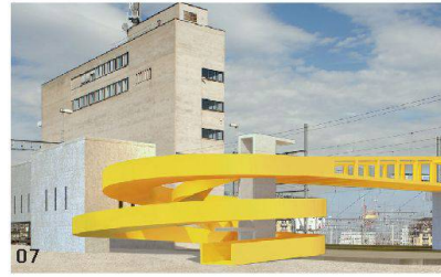
06–08 «RAL 1023»: Der «dynamische» Verkehrsweg aus einem dreifeldigen Vierendeelträger in Analogie zu den Fahrleitungsjochen der Bahn mit spiralförmigen Rampen aus Stahl wurde von der Jury städtebaulich und funktional kontrovers diskutiert. Der vorgeschlagene Längseinschub von einer Seite aus über Hilfsstützen im Gleisfeld ist bewährt und technisch machbar, benötigt allerdings zusätzliche Aussteifungen
