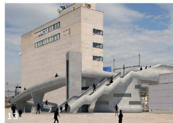
12–14 «Continu»: Trogbrücke mit Doppelpfeilern. Zwischen den 4 m hohen Betonwänden entsteht trotz Fensteröffnungen wenig Aufenthaltsqualität, zumal die ausgestellten Gesimse den Ausblick behindern. Der Bau der monolithischen Konstruktion erfolgt in Segmentbauweise aus vorfabrizierten Beton-elementen. Die Jury lobt die gute konstruktive Durcharbeitung und die formale Konsequenz
