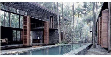
01 Palmyra-Haus (Nandgaon, Maharashtra, 2007). Zwischen zwei Flügeln liegt ein kühlender Pool, die Aussenwände verfügen über verschiebbare Holzpaneele (Foto: Hélène Binet)
