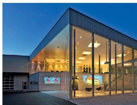
Die Filigranverglasung «swiss Fine Line» erfüllt hohe Ansprüche bezüglich exklusiven Architekturdesigns. Die Rahmenprofile werden umlaufend in Boden, Decke und Seitenwände eingearbeitet, wodurch fliessende Grenzen zwischen Innen und Aussen entstehen.
