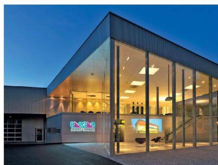
Die Filigranverglasung «swiss Fine Line» erfüllt hohe Ansprüche bezüglich exklusiven Architekturdesigns. Die Rahmenprofile werden umlaufend in Boden, Decke und Seitenwände eingearbeitet, wodurch fliessende Grenzen zwischen Innen und Aussen entstehen.
