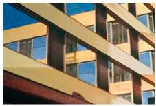
Gerber-Vogt zeigt drei Neuheiten: Am Beispiel der kürzlich fertiggestellten Fassade des Universitätskinderspitals beider Basel (UKBB) wird eine komplexe Fassade mit spezieller Brüstungsverglasung gezeigt, zu sehen ist das neue Wechselrahmen-Holz/Metall-Fenster-System AGM WR-8500 und das Brandschutzfenster AGM ISO-8400 El 30, Holz/Metall, 2-flügelig, bis 5.5 m² Fensterfläche. Dazu wird das gesamte Kerngeschäft in den Bereichen Fassadenbau und Dachoberlichter präsentiert.
