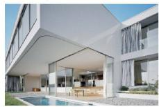
Seit 2002 bewähren sich die 2fach-Isolierverglasungen «Sky-Frame 2» mit den nur 30 mm schlanken Isolierglaselementen. Neu wird das Schiebefenstersystem «Sky-Frame 3» präsentiert. Diese Weiterentwicklung arbeitet mit 54 mm starken 3fach-Isolierglaselementen. «Sky-Frame 3» ist damit als Schiebefenster auch für den Einsatz bei sehr hohen Anforderungen an die Wärmedämmung prädestiniert. Das neue Ganzglasgeländer ergänzt die Produktelinie.
