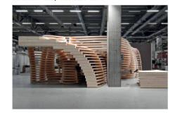
Zwanzig Ebenen aus 50mm starken Fünfschichtholzplatten werden alternierend mit 13 cm hohen Distanzelementen aus demselben Material aufeinandergestapelt, sodass ein organisch geformtes Gebilde entsteht. Es führt die Besuchenden in der Figur einer «räumlichen Acht» durch fliessend ineinander übergehende Atmosphären. Diese Ausstellungsarchitektur soll als begehbare Holzskulptur die Neugier für die Gestaltungsmöglichkeiten mit Holz wecken und exemplarisch das Potenzial im Holzbau aufzeigen.
