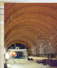
DELTA-MS 20 Zuverlässige Drainageeigenschaften im Tunnelbau
