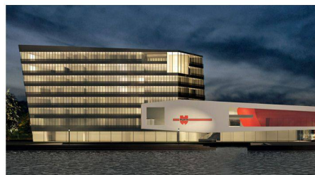
12 «Die Liegende»: Kombination aus einem flachen Gebäude für den Kongresssaal und einem 42 m hohen Hochhaus mit Büronutzung (Carlos Martinez Architekten, bb architektur)
