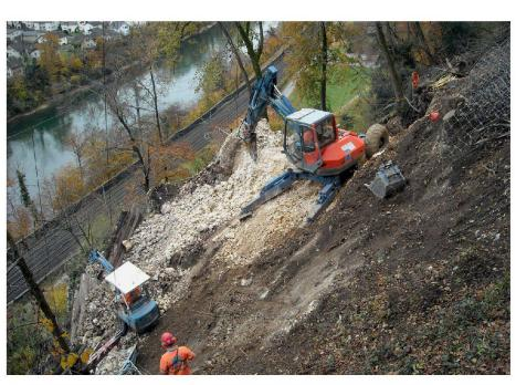
02 Der mechanische Felsabtrag erfolgte mittels Schreitbagger und Hydraulikhammer. Die obersten 12 m des Felspfeilers, die von Hand mittels Presslufthammer abgetragen wurden, sind hier bereits entfernt. Eine Seilbahn erschloss die Baustelle an exponierter Lage (Fotos, Plan und Diagramm: Geotest AG)
