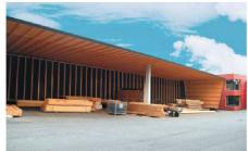
02 «Hauer Holztechnik Halle»: Bescheidene Überdachung mit verstecktem Tragwerk (Foto: holzheu/ecoplus)
