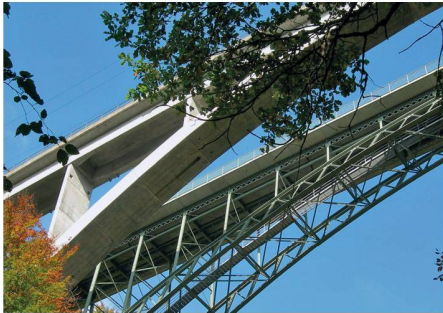
01 Schwarzwasserbrücke (Foto: Eugen Brühwiler)
