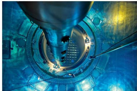
Blick in einen offenen Reaktor des Kernkraftwerks Beznau, wo während einer Revision verbrauchte Brennelemente ausgetauscht werden. Dieses Bild sowie jenes auf Seite 15 sind Teil einer Fotoarbeit von Luca Zanier zum Thema «Raum und Energie»
