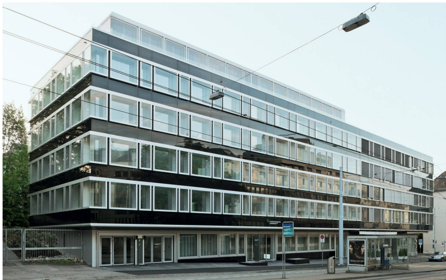
01 Zwei Generationen Glasfassaden (Fotos: Dominique Marc Wehrli)
