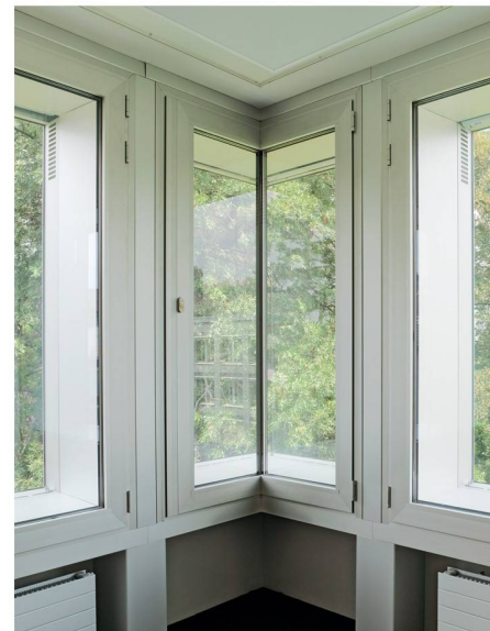
02 Das Eckfenster löst die Gebäudeecke im Inneren auf
