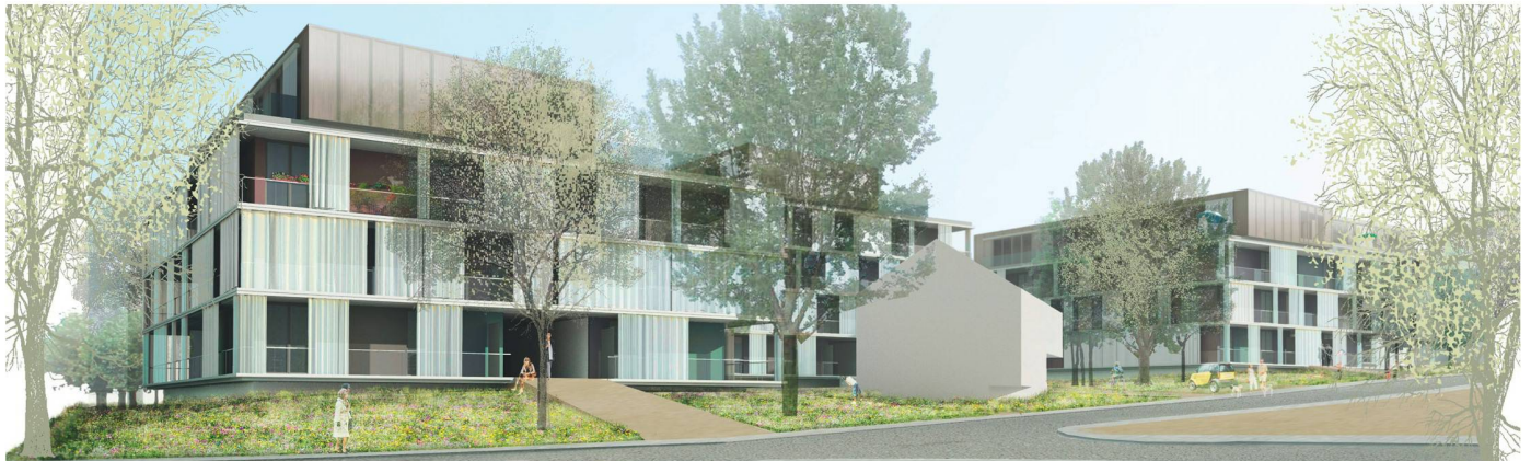
01 Zur Weiterbearbeitung und Ausführung: Flexible Membrane vor den umlaufenden Balkonen prägen die Wohnkuben im öffentlich konzipierten Grünraum. Das kleine Satteldachhaus nimmt die Kinderkrippe auf (Visualisierung: agps)
