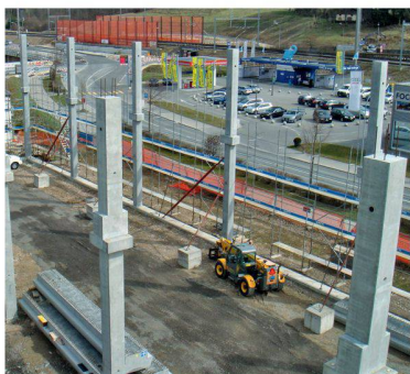
Bild 1: Die fertig montierten Stützen, Bild 2: Montage der Träger, Bild 3: Montage der Rippenplatten
