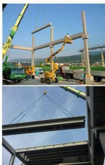
Bild 1: Die fertig montierten Stützen, Bild 2: Montage der Träger, Bild 3: Montage der Rippenplatten
