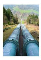
Druckleitung Rempen des Kraftwerks Wägital mit Standseilbahn. Blick von der Apparatekammer zur Zentrale Rempen, dahinter das Ausgleichsbecken der unteren Kraftwerksstufe (Foto: Peter Würmli)
