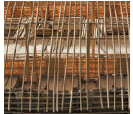
01+02 Modell und Konstruktionsdetail: Langhaus der Kaluli aus Papua-Neuguinea. Die Häuser sind durch die Sippe gemeinschaftlich aus roh belassenen Stämmen erstellt, mit Lianen verkleidet und von bis zu 60 Personen bewohnt. Es handelt sich um grosse Einraumhäuser auf Stelzen. So werden Schäden aus Überschwemmungen vermieden, und die Konstruktion ist ringsum effizient belüftet (Fotos: vinipphoto, Virginie Otth und Nicolas Lieber)
