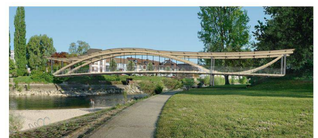
11 Gedeckte Holzbrücke mit unterspannter Bogenkonstruktion
