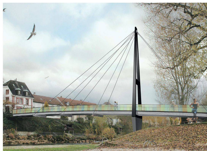
05 Schrägseilbrücke mit A-förmigem Pylon, drei Abspannungen im Hauptfeld (Spannweiten 17.7, 11.0, 13.0 und 12.7 m) und konstanter Trägerhöhe
