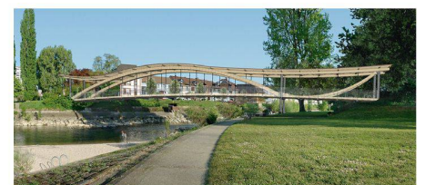
11 Gedeckte Holzbrücke mit unterspannter Bogenkonstruktion
