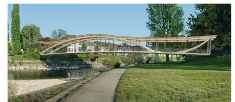
11 Gedeckte Holzbrücke mit unterspannter Bogenkonstruktion
