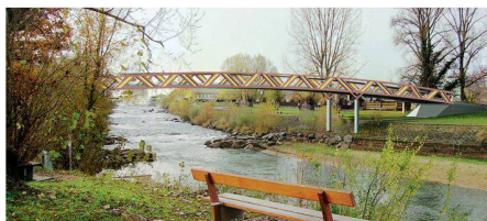
06 Zweifeldrige Fachwerkbrücke mit aussen liegendem flachbogenförmigem Diagonalfachwerk
