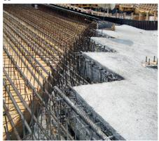
06 Grundriss Betonboden mit Spannkabeln in den lastabtragenden Bogenbereichen. Grau unterlegt die grossen Betonstärken d=60cm resp. d = 80 cm. (Plan: WMM AG) 07 + 08 Bewehrungsführung Bogen-Platten-Bereich (Pläne + Fotos: B+G GmbH) 09 Mock-up der Bewehrung entlang Patiorand 10 Arbeitsfuge beim Schalenauflager
