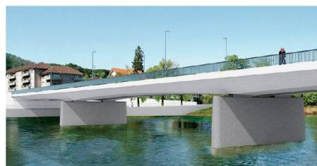
05 «Zweistein»: Der Querschnitt des Dreifeldträgers kann als trapezförmige Platte mit Längsnut oder als zweistegiger Plattenbalken mit breiten Stegen betrachtet werden. Die Trägerhöhe verläuft dem Momentenverlauf entsprechend leicht gekrümmt. Die Pfeiler werden um etwa 1.80 m aufbetoniert
