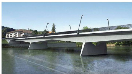
03 «Tangram»: Die vorgespannte Brücke ruht auf zwei stark gevouteten Längsträgern (niedrige trapezförmige Vollquerschnitte, Hohlkästen zu den Pfeilern hin). Die Aussenflächen erscheinen entlang einer schräg verlaufenden Knicklinie gefaltet
