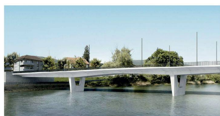
07 «Houdini»: Die Brücke besteht aus einem zweistegigen vorgespannten Plattenbalken mit schlanke, nach innen geneigten Stegen. Die Trägerhöhe nimmt in den Seitenfeldern linear gegen die Pfeiler hin zu, im Mittelfeld ist sie parabolisch überhöht. Die Pfeiler sind im oberen Teil Y-förmig aufgelöst
