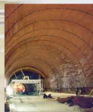
DELTA-MS 20 Zuverlässige Drainageigenschaften im Tunnelbau
