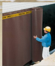
DELTA-MS Sauberschicht, Grundmauerschutz und Sickerschicht
