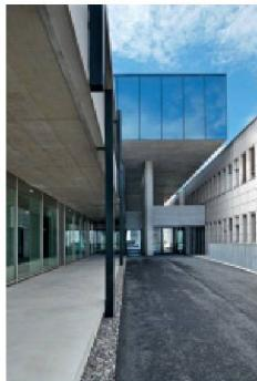
Für das neue Gebäude der International Union for Conservation of Nature in Gland VD wurden 41 % der insgesamt verwendeten Betonkubatur als RC-Beton ausgeführt (mit 50 % RC-Granulaten). Architektur: agps architecture, Zürich; Tragwerk: Guscetti & Tournier SA, Carouge; Betonlieferant: PQR Béton SA, Gland Baujahr: 2010 (Foto: Holcim Foundation)
