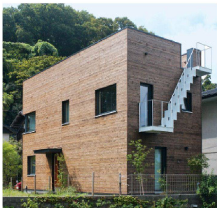
01 Das erste Passivhaus Japans ist eine zwei-stöckige Holzkonstruktion mit Dachterrasse (Fotos: Key Architects)
