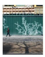
Profilglasfassade des Sockelgeschosses an der Badenerstrasse. Da die Montage der vorgehängten Fassadenelemente aus Glasfaserbeton im Obergeschoss noch nicht abgeschlossen ist, haben wir auf dem Titelfoto ein paar fehlende Platten eingefügt (Foto: af / Red.)
