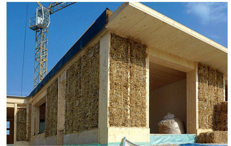
02 Holzständerbau mit eingebrachten Strohballen
