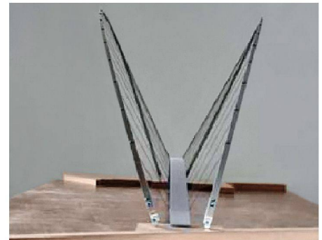
01 Schmetterlingsbrücke – ein neuartiger Öffnungsmechanismus (Foto: Lee Franck)
