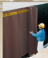
DELTA-MS Sauberkeitsschicht, Grundmauerschutz und Sickerschicht
