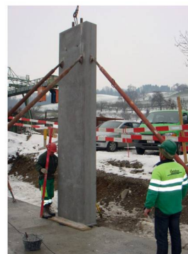
Die fertig versetzte und fixierte Stütze
