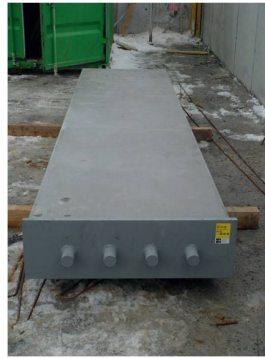
Die ausgelieferte Stütze, zur Montage bereit
