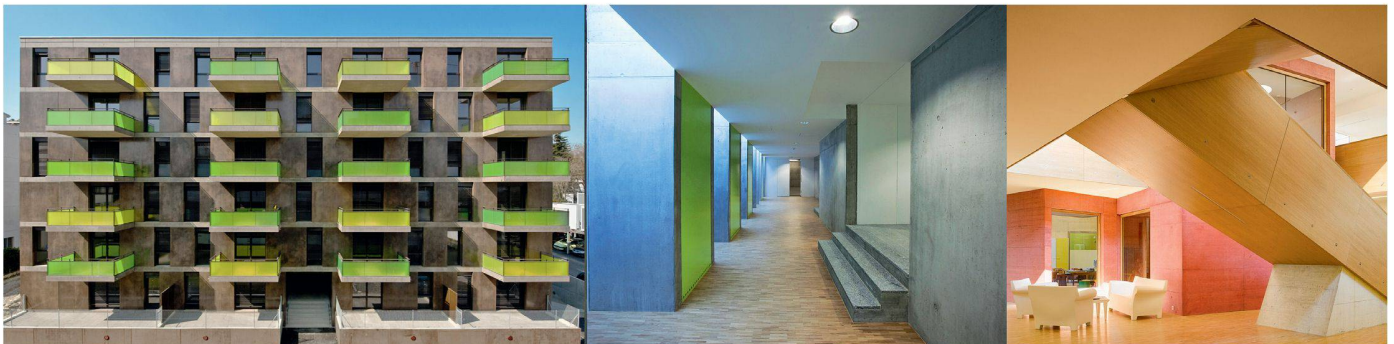
06 Immeuble de logements Les Genêt, Genève (GE), Atelier d'architecture Jacques Bugna (Foto: Barro Julien)
