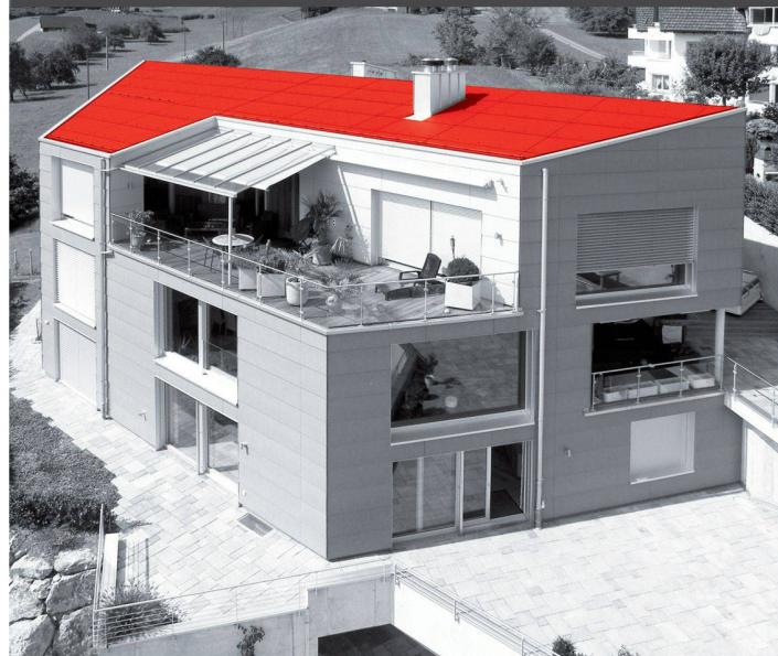
Mit nur 6° Minimalneigung ist das INTEGRAL PLAN Dachsystem kein Flachdach, aber das Flachste in seiner Kategorie. Die Plattenmodule von bis 2500 x 1220 mm sorgen für das eigenständige Design.
